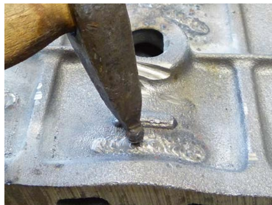
Kurze Schweißraupe nach dem Entfernen der Schlacke
